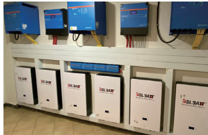
6* B-LFP48-200PW 60kWh
