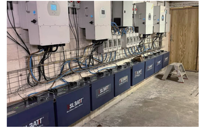
8* B-LFP48-170E 36kWh
