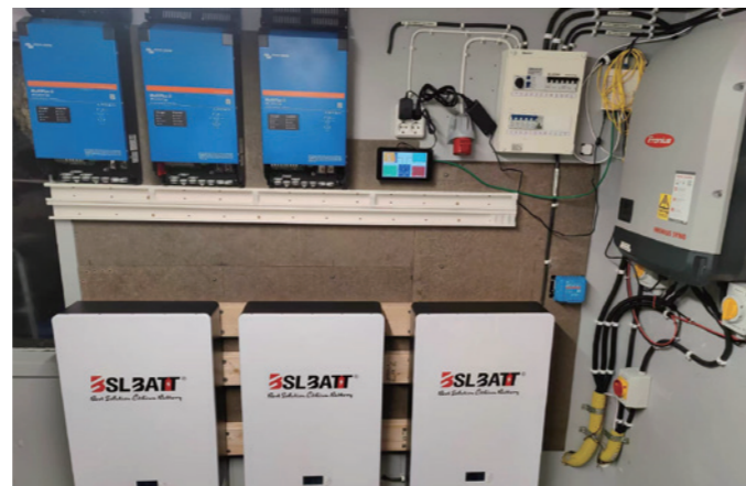
3* B-LFP48-200PW 30kWh
