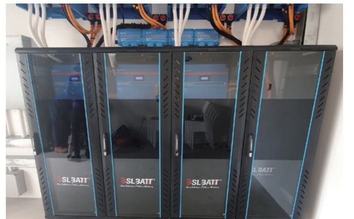
10* B-LFP48-200E 107kWh
