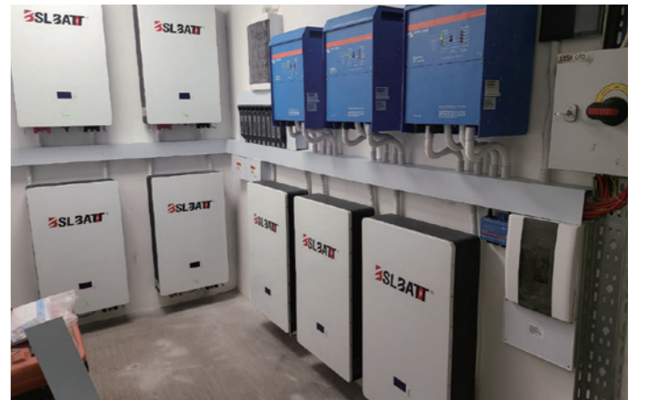
7* B-LFP48-200PW 70kWh
