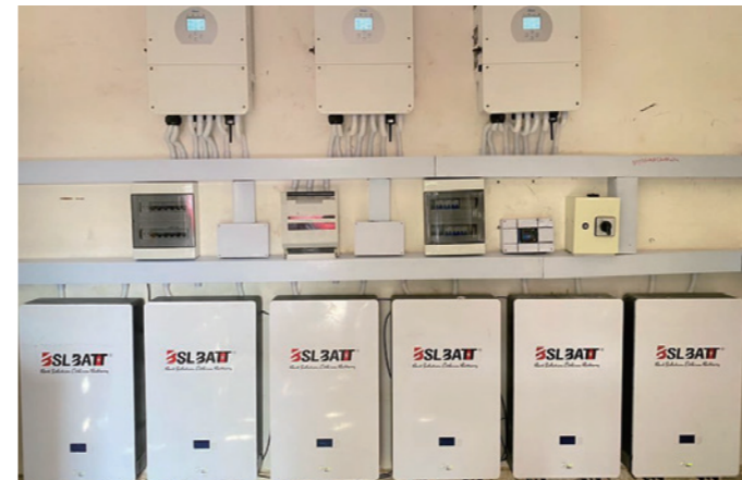
6* B-LFP48-200PW 60kWh
